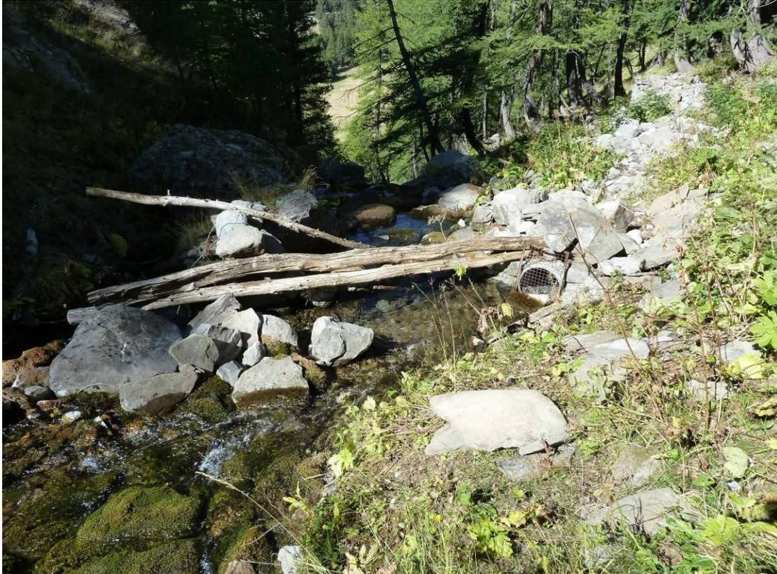
Prise d'eau et extrémité de la conduite d'amenée
