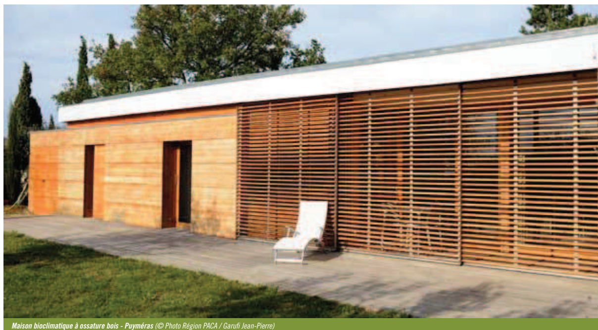
Maison bioclimatique à ossature bois - Puyméras (© Photo Région PACA / Garuffi Jean-Pierre)
