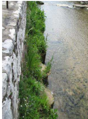
ill. n° 20. Station de Consoude bulbeuse coincée entre palplanches métalliques et pied de murs Photo C. Buton, Cab. X-AEQUO
