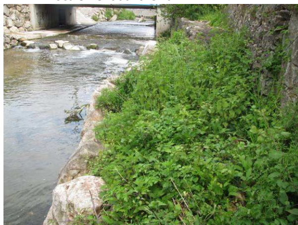
ill. n° 6. La Mourachonne à environ 150 m en amont du site fortement canalisée entre ouvrages maçonnés et enrochements massifs, vue prise vers l'amont (photo : C. Buton, Cab. X-AEQUO)
