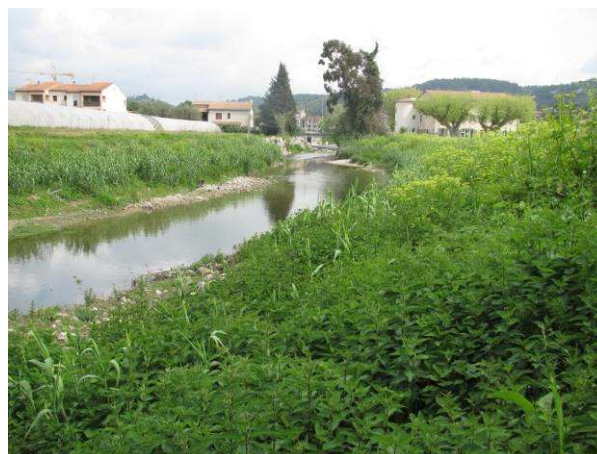
ill. n° 7. La Mourachonne juste en amont du site, rectifiée en 2006-2007 avec confortement local en matelas gabions sous treillis métallique, vue prise vers l'amont (photo : C. Buton, Cab. X-AEQUO)
