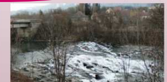
Ouvrage sur le Drac - Commune de Saint-Bonnet (Hautes-Alpes)
