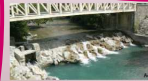
Ouvrage sur le Buech - Commune de Les Savoynes (Hautes-Alpes)
