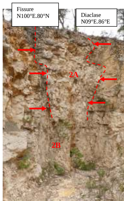
Photographie n°06 : fissure désolidarisant la masse 2A
