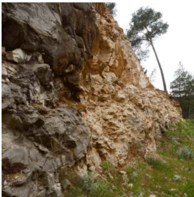
Photographie n°80 : Aperçu des nombreuses pierres posées sur le talus 7W
