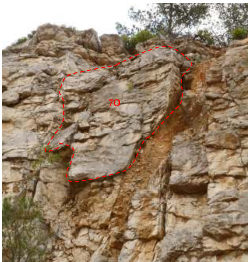
Photographie n°63 : Masse 7O posée dans une zone de brèche partiellement lessivée
