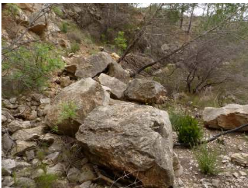
Photographie n°32 : Exemple de blocs effondrés du paquet rocheux et tombés sur la plateforme
