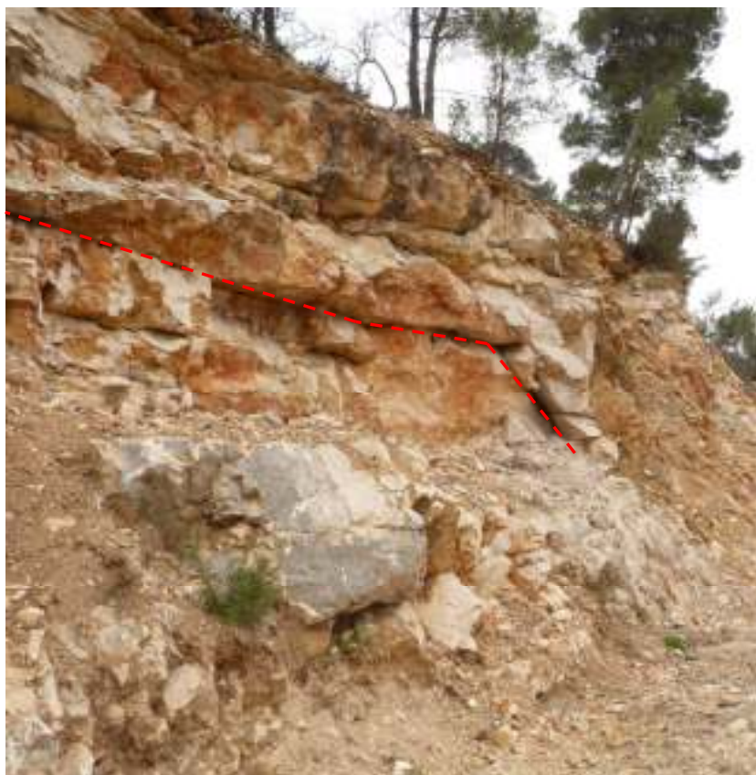
Photographie n°02 : plan de rupture visible dans le talus
