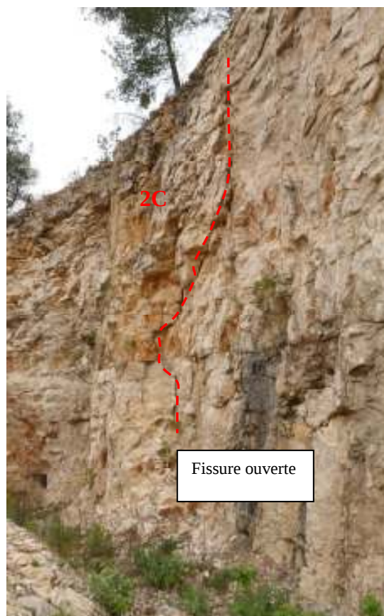
Photographie n°10 : fissure ouverte désolidarisant l'écaille 2C du massif rocheux
