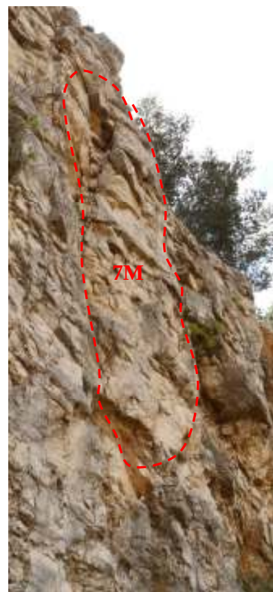
Photographie n°60 : ensemble 7M désolidarisé du massif rocheux
