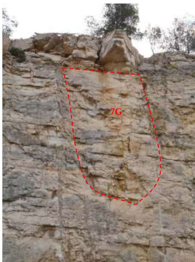
Photographie n°51 : dièdre 7G soutenant le surplomb 7C
