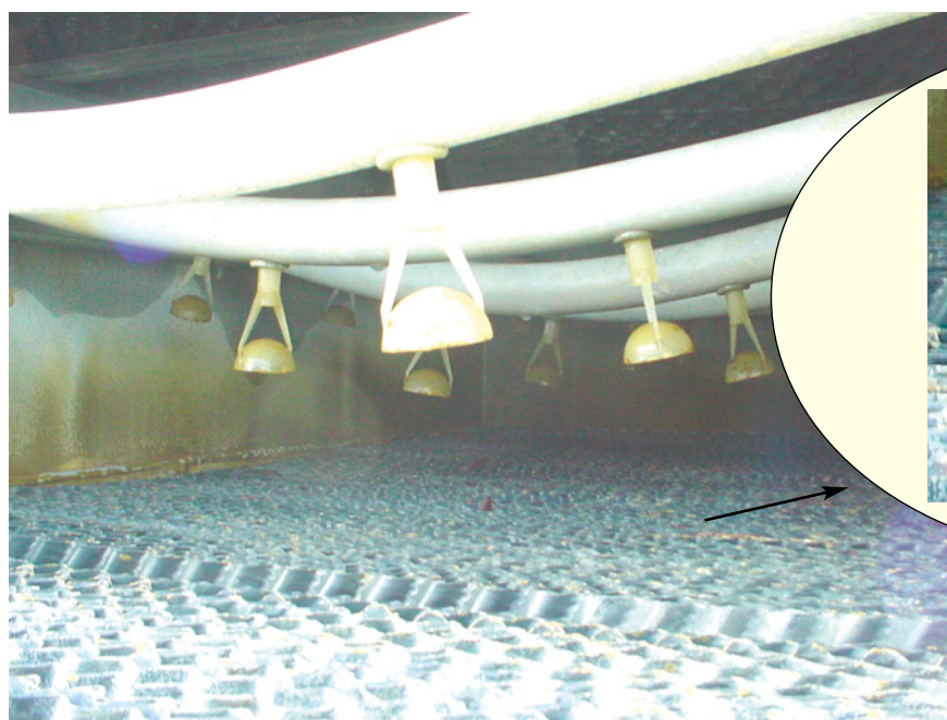
Présence de tartre dans un corps d'échange
