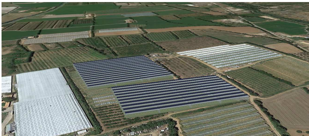
Insertion du projet dans le paysage – vue rapprochée
