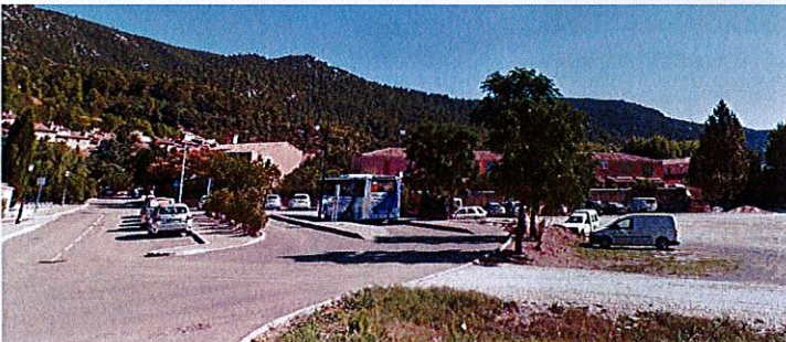
Vue prise au croisement du chemin des Ferrages et du chemin Saint-Peire, au droit de la création du giratoire ouest, de la gare routière et du parking existants (en rive droite du Raby).
