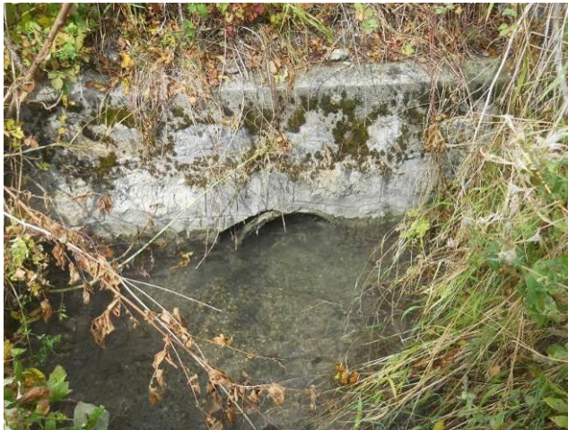
photo 3 : exutoire aval de la buse
