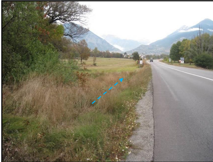
photo 6 :illustration du débordement potentiel du torrent vers sa rive gauche en amont de la RN 94
