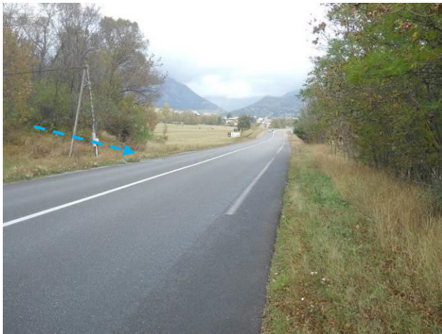
photo 2 : arrivée du torrent de Pierre Feu en amont de la RN 94
