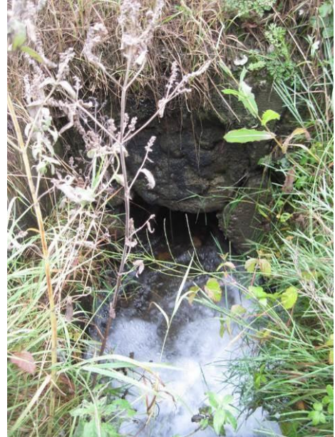
photo 4 : entonnement amont de la buse sous la RN 94
