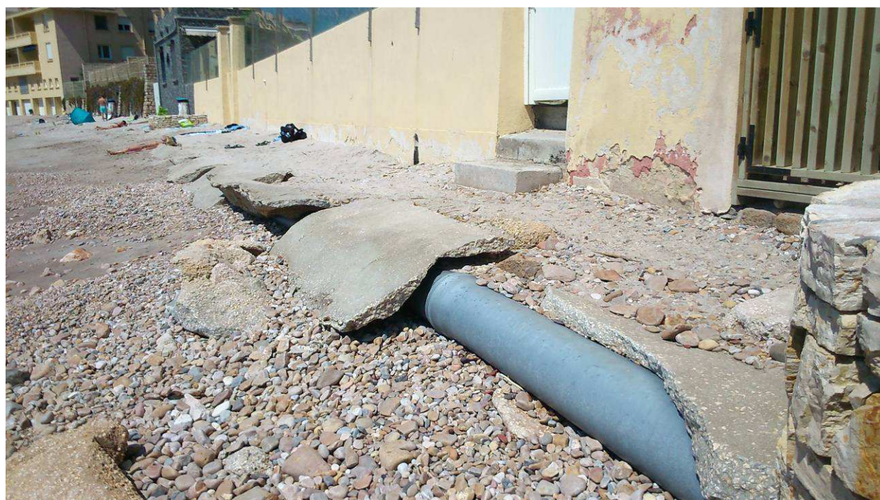
Photo 4: Tronçon entre regard 4 et 3 (2016)
