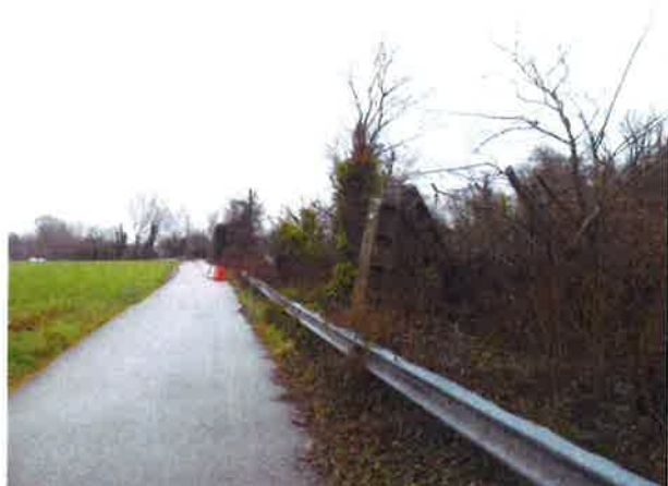
4 - Chemin des Brotteaux et rambarde de sécurité (plan d'eau à droite du chemin)
