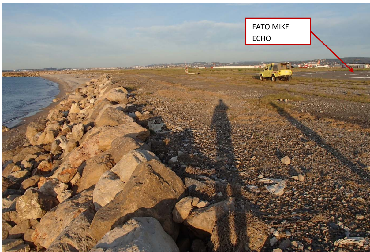
Photo 1 - Digue devant la FATO MIKE ECHO (ICTP – juin 2016)
