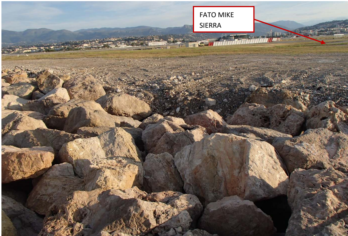
Photo 3 - Digue devant la FATO MIKE SIERRA (ICTP – juin 2016)
