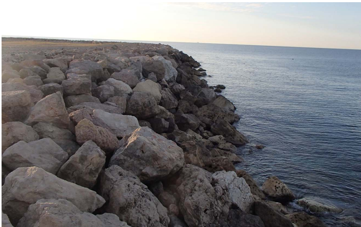
Photo 4 - Digue devant la FATO MIKE SIERRA (ICTP – juin 2016)
