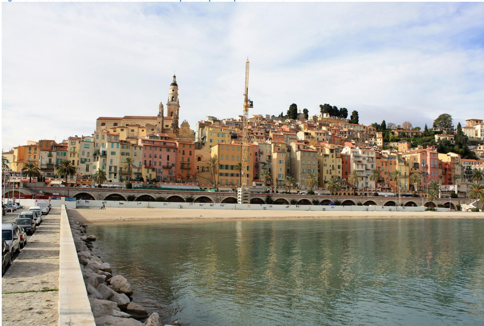
Figure 3. Pendant l'exécution du chantier : vue depuis le quai Napoléon III vers la Vieille Ville de Menton.
