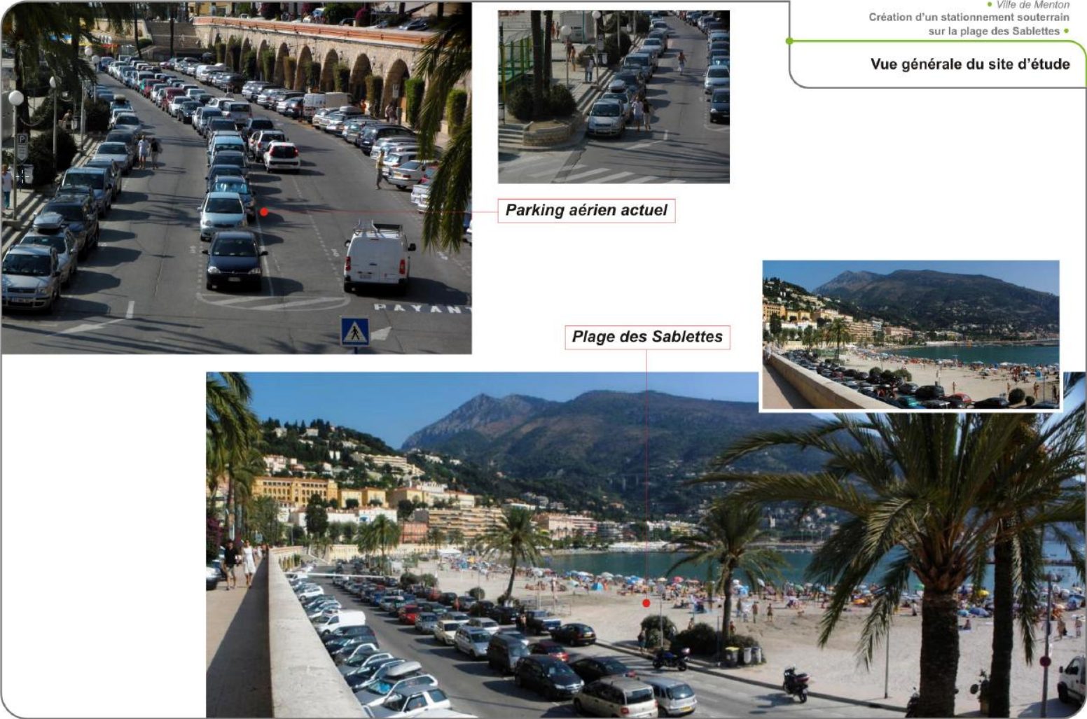
Figure 2. Vue générale du parking aérien de la plage des Sablettes sous lequel le projet de parking souterrain sera construit
