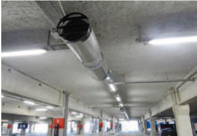
Le débit sera au maximum de  $600 \text{ m}^3 / \text{h}$  / emplacement de voiture. La vitesse de l'air au niveau des grilles d'amenée d'air et d'extraction sera inférieure à 5 m/s. Les ventilateurs doivent normalement assurer leur fonction avec des fumées à  $200^\circ \text{C}$  pendant une heure (certificat de résistance au feu «  $200^\circ \text{C}$  une heure », délivré par un organisme certifié).
