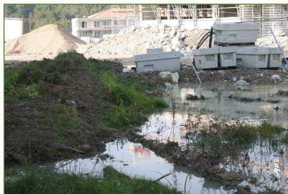
Action des engins de chantiers
