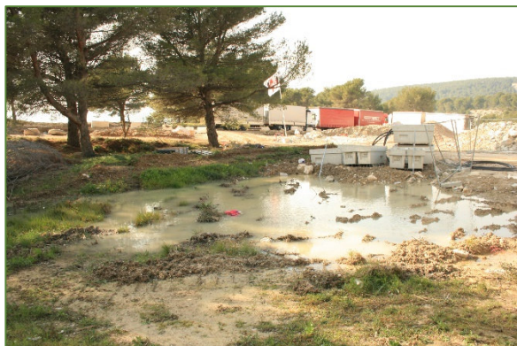
Action des engins de chantiers
