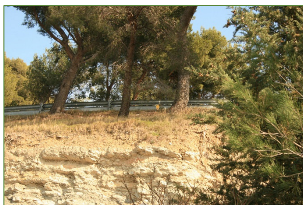
Talus en Espace Boisé Classé
