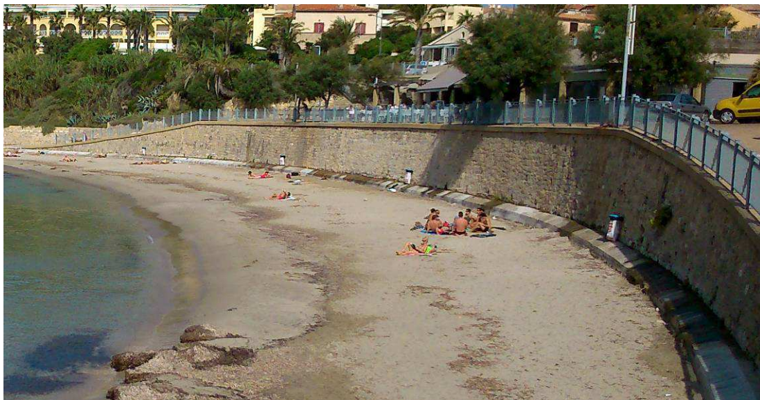
Photo 4: mur de soutènement de l'Esplanade Dumas en octobre 2014
