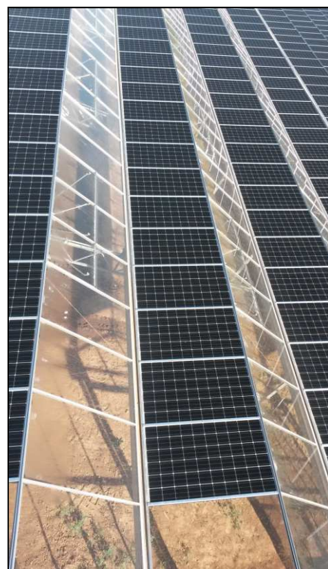
Pans nord vitrés Pans sud équipés de panneaux photovoltaïques
