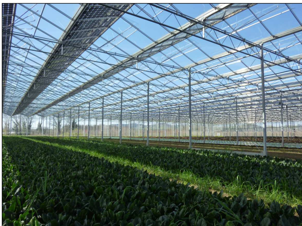
Serre du lycée agricole E.RESTAT – Sainte Livrade sur Lot (47)
