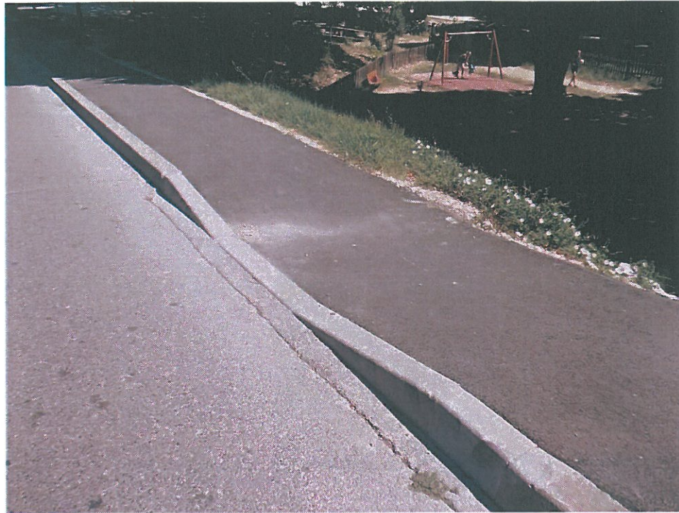
PHOTO 8 : POINT BAS SUR TROTTOIR
