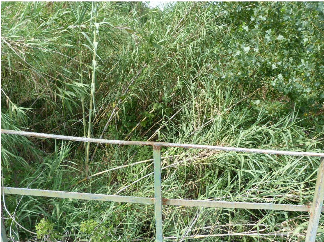
Photo 4 : Canal des Iscles depuis l'ouvrage de franchissement (source EPA)
