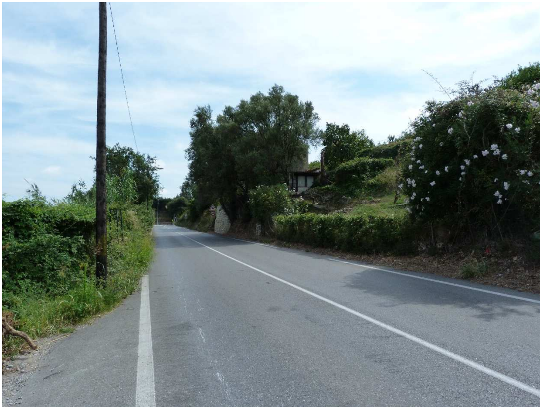
Photo 6 : RM 2209 et ses abords : vue vers le sud (source EPA)
