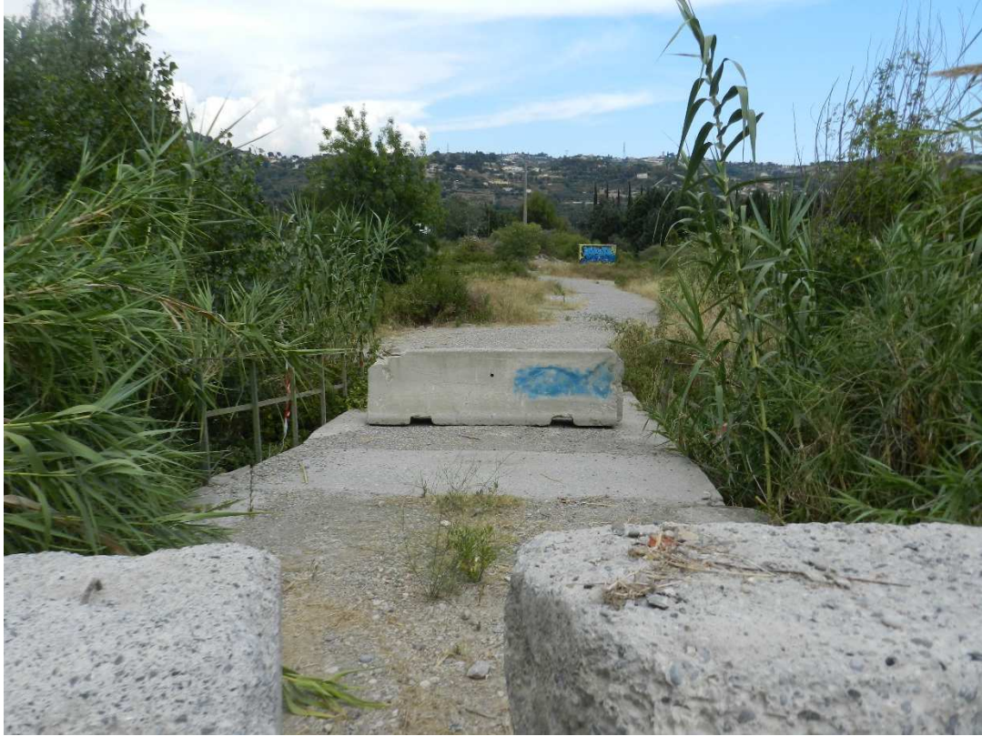
Photo 5 : Accès existant depuis la RM 2209 (source Ingerop)
