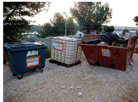
Zone de tri de déchets sur base vie avec conteneurs clairement identifiables et adaptés en nombre et volume de stockage - Source : INGEROP
