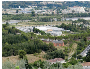
Le CREAT vu depuis les coteaux de La Gaude - Source : INGÉROP
