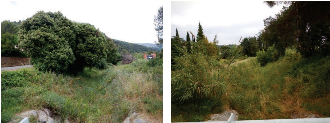
Vu sur le canal des Iscles au droit de l'aire d'étude – Source : INGÉROP
