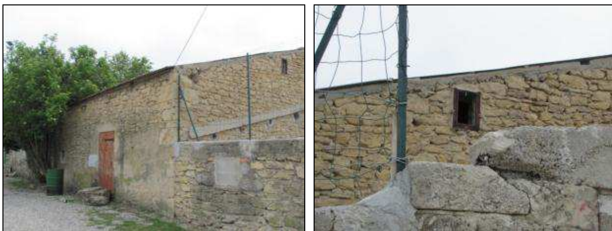
Bâtiment dans le secteur n°9 (gîte potentiel) À droite : zoom sur l'ouverture favorable
