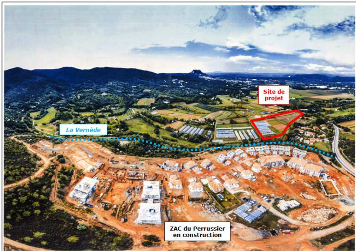
Figure 4 – ZAC du Perrussier le 16/10/2015 Source : mairie de Roquebrune sur Argens
