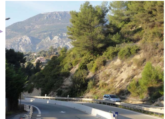
Vue depuis le centre d'exploitation ESCOTA, de la bretelle à aménager
