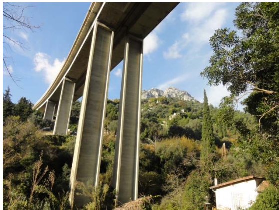
Vue vers l'ouest du viaduc depuis le vallon
