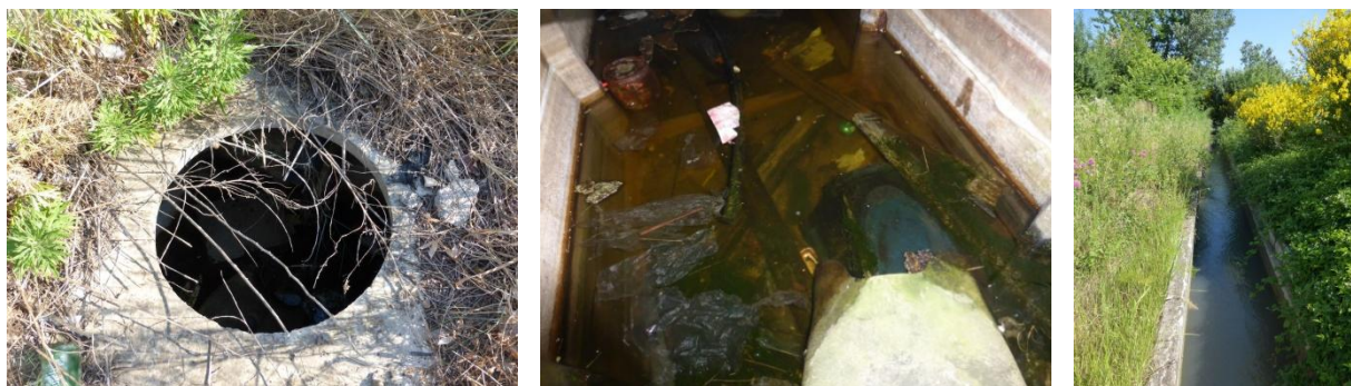
Figure 10 : Canal non favorable aux amphibiens (à gauche) et retenue d'eau (au centre et à droite). Photos : NATURALIA
