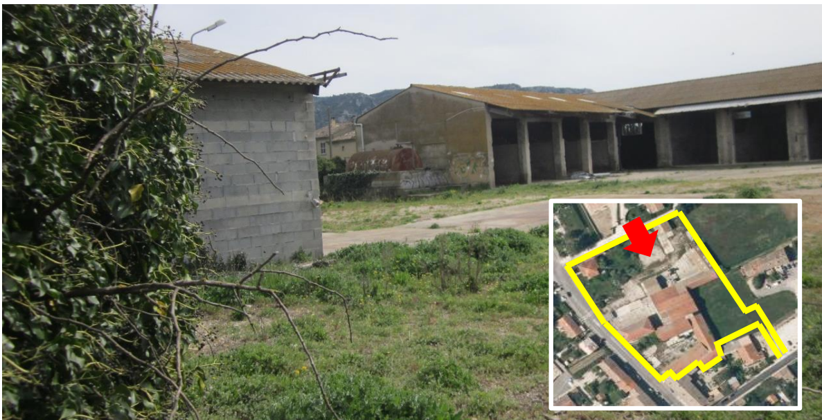
Vue sur les bâtiments (côté Nord)
