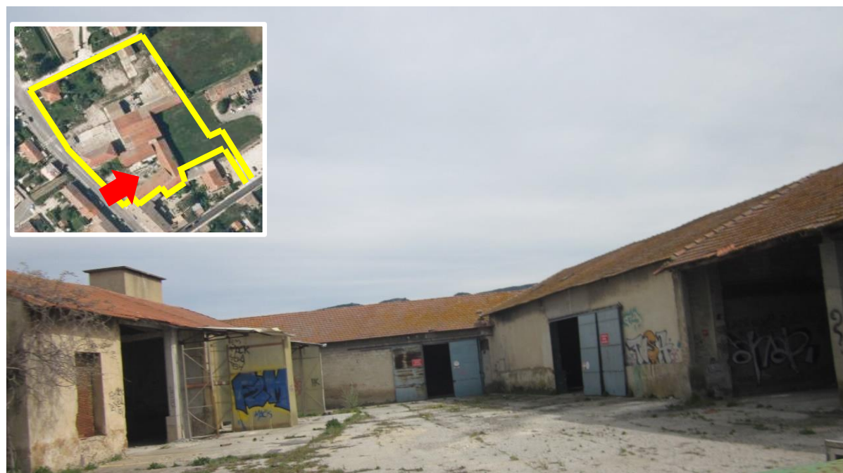
Vue sur les bâtiments et la cour Sud
