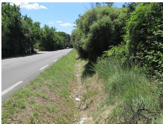
Figure 10 : Talus dégradé de bord de route
