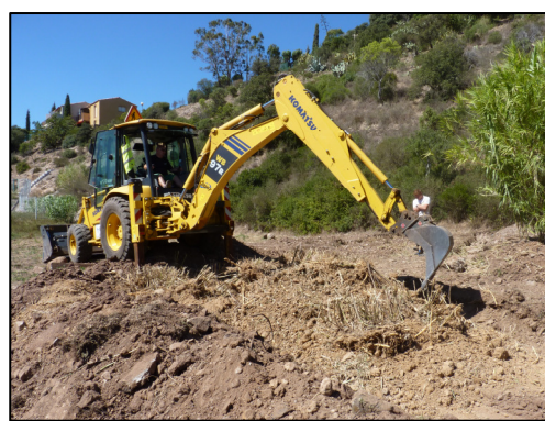
Exemple d'assistance technique par la Ville de Saint-Raphaël Chantier Vallon Epsilon II
