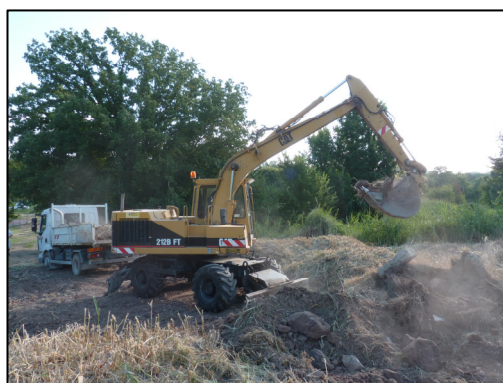
Exemple d'assistance technique par la Ville de Fréjus Chantier Giratoire CG83
