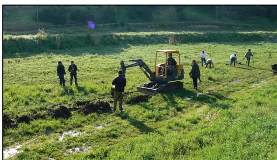
Agents et ouvriers en intervention dans le fond du bassin du Castellas
