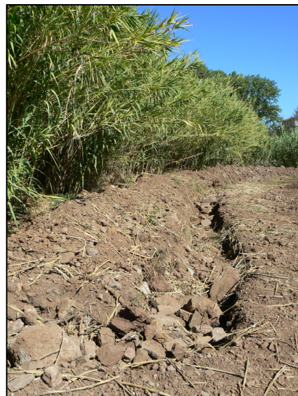
Tranchée de 50cm de profondeur sur 40 cm de large réalisée sur toute la longueur du cannier d'Arundo donax
