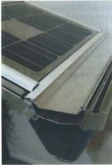
Photo 1 : Intégration du panneau solaire en toiture
