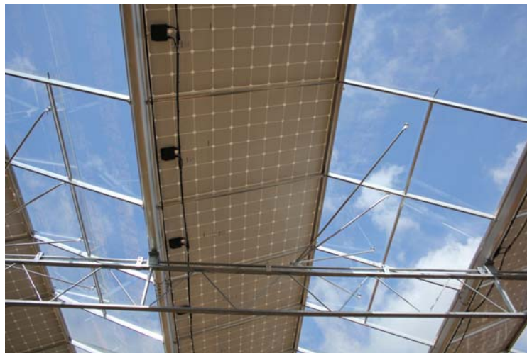
Photo 2 : Toiture en panneaux monocristallins
