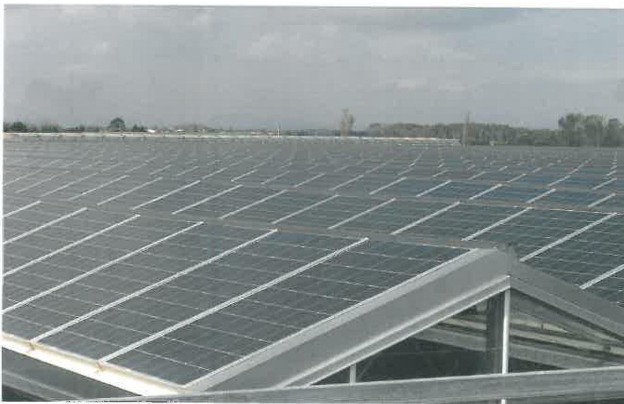
→ TOITURE D'UNE SERRE, PAN DES PANNEAUX PHOTOVOLTAÏQUES
