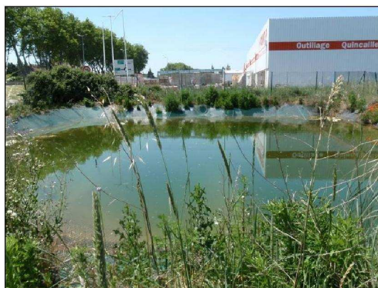
Photographie 3 : Le bassin de rétention présent au Sud-Ouest du site
