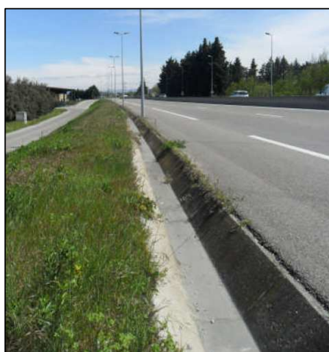
Figure 7 : Caniveau de drainage de la RD99
