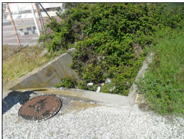
Figure 8 : Ouvrage d'engouffrement des eaux pluviales sous le site de projet
