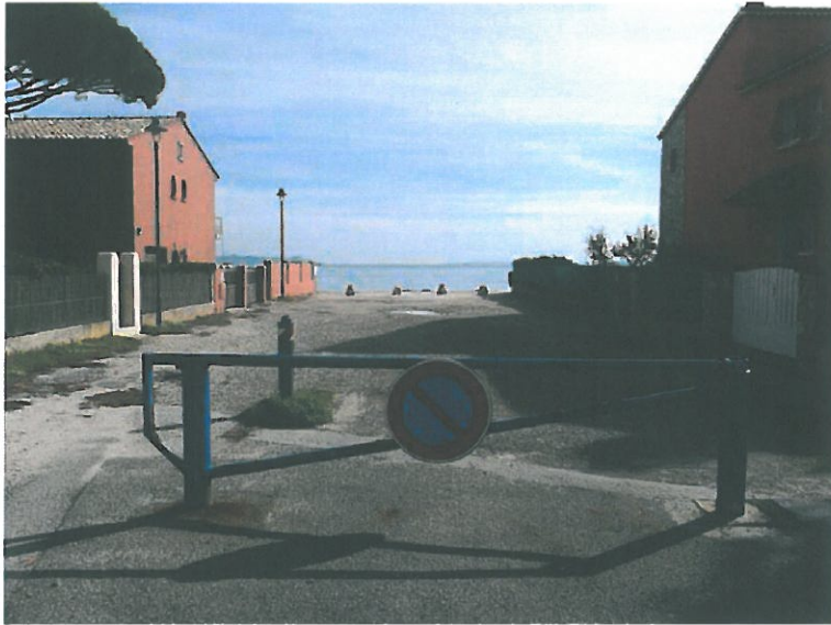
Zone des installations chantier (stockage – chargement – déchargement)
