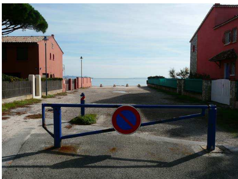
Figure 16 : Zone des installations chantier (stockage – chargement – déchargement)
