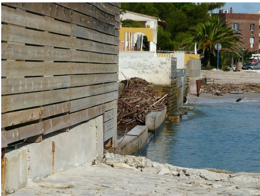
Figure 7 : partie centrale de l'anse de la potinière : absence de passage piétonnier
