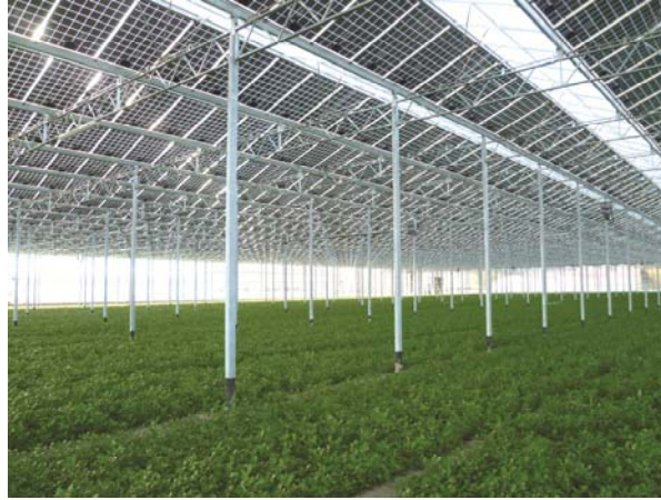
Culture de Cresson dans la serre FONROCHE de Boé (47)
