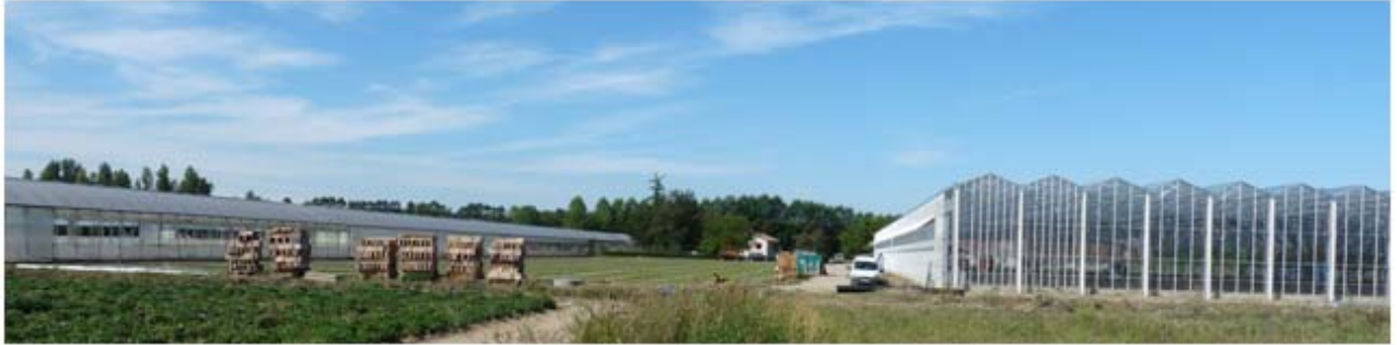
Exemple de serre agricole photovoltaïque FONROCHE (à droite)
