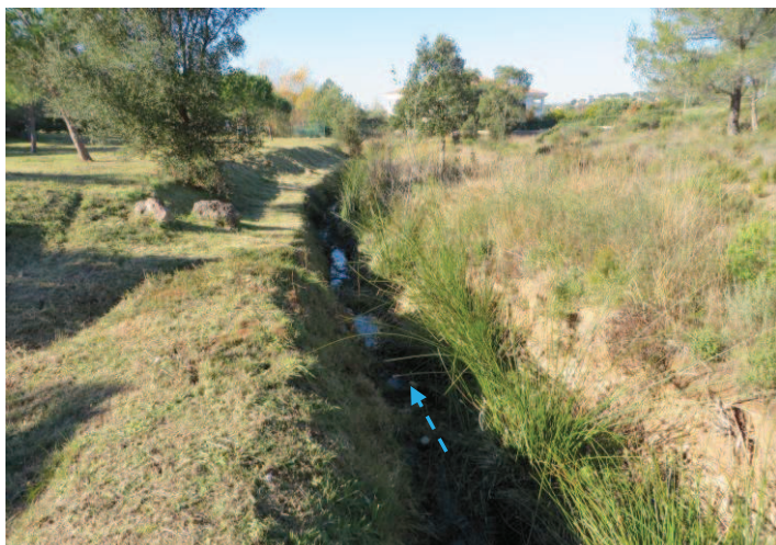
11. Ruisseau BV Ouest 100m en aval de l'exutoire de la zone projet Ouest sous l'avenue des golfs : calibré et entretenu mais matériaux naturels et végétalisé. Zannichellia palustris , hydrophyte protégé en PACA sur le fond.
