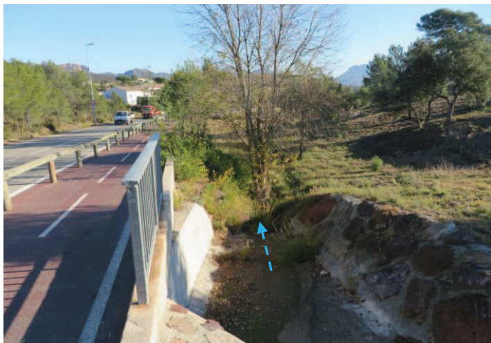
7. Exutoire du versant Est de la zone de projet dans le ruisseau de Valbonnette
