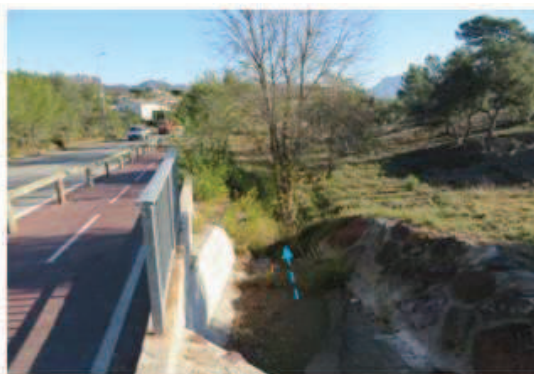
7. Exutoire du bassin pluvial Est dans le ruisseau de Valbonnette
