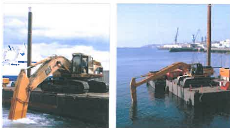
Figure 2 : Exemple de pelles mécaniques sur ponton flottant et de type bras long
