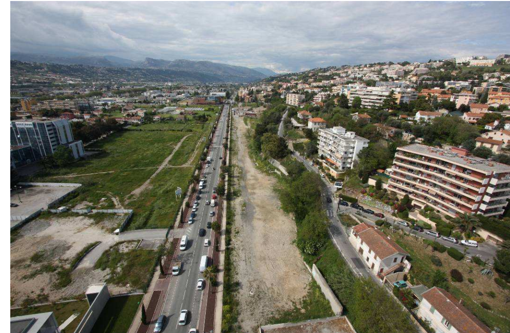
Vue depuis le démarrage de l'extension vers le nord, et la voie des 40 m actuellement à 2 voies.
