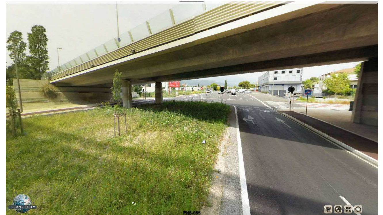
8- Sous le viaduc de l'autoroute vers le nord (terminus)
