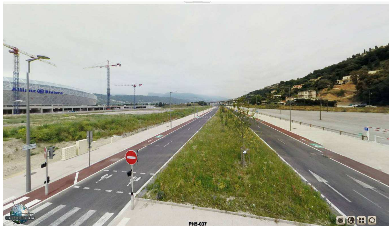
6- Au sud du stade Allianz riviera vers le nord
