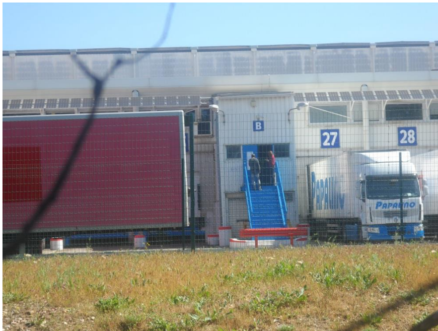
Zone 2 – escalier accès bureaux – Porte B
