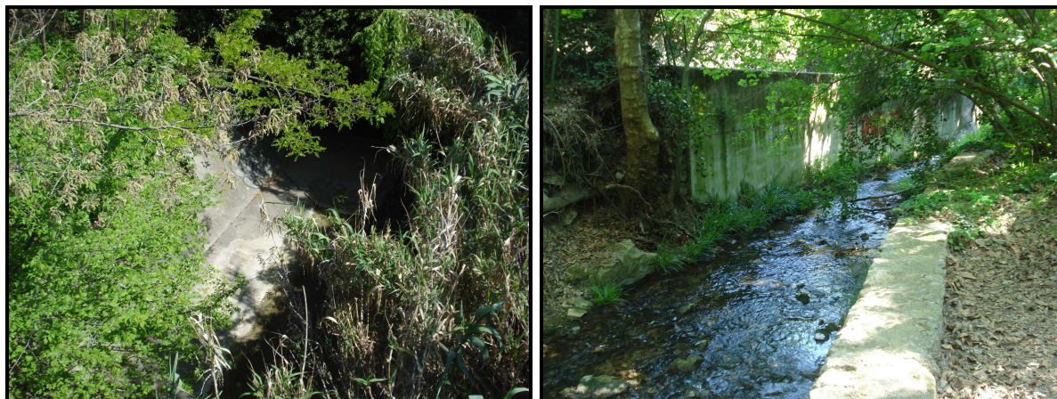
Vue du lit mineur bétonné et des murs le bordant localement
