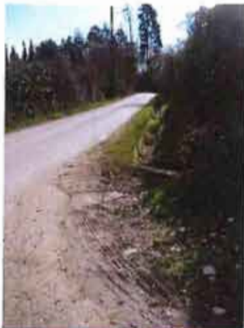
Vue aval du vallon – fossé du vallon en bord de route
