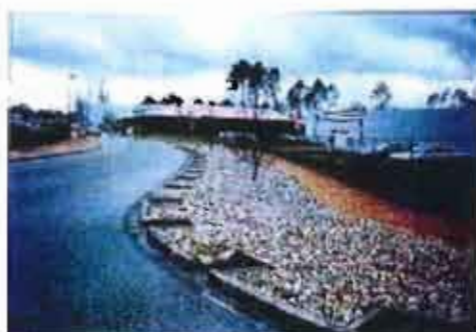
Figure 4 : Exemple de tranchée drainante
