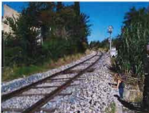
Vue de la voie SNCF au niveau des ouvrages – Est/Ouest
