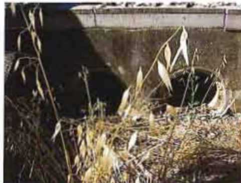
Vue 1 de l'ouvrage hydraulique principal
