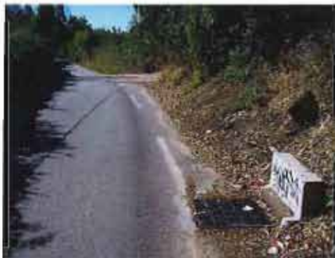
Vue de la route du vallon sec de Bouenheure – Nord/Sud
