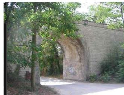
Pont voie ferrée, Chem Bastide des Tourelles
