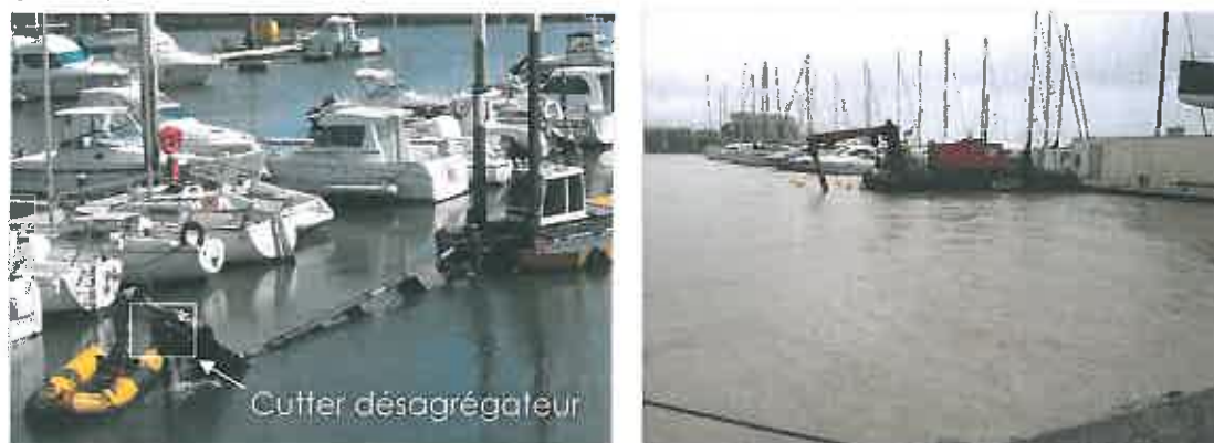
Figure 2 : Drague Aspiratrice Stationnaire : exemple à gauche et mise en œuvre dans la darse du Bourrian à droite
