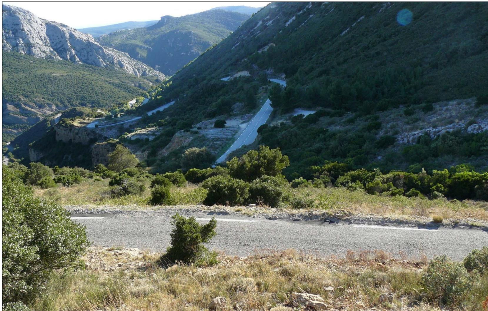
Figure 26 Différence de traitement de la chaussée sur la RD 2 : au premier plan, la chaussée dégradée ; au second plan, la chaussée reprise
