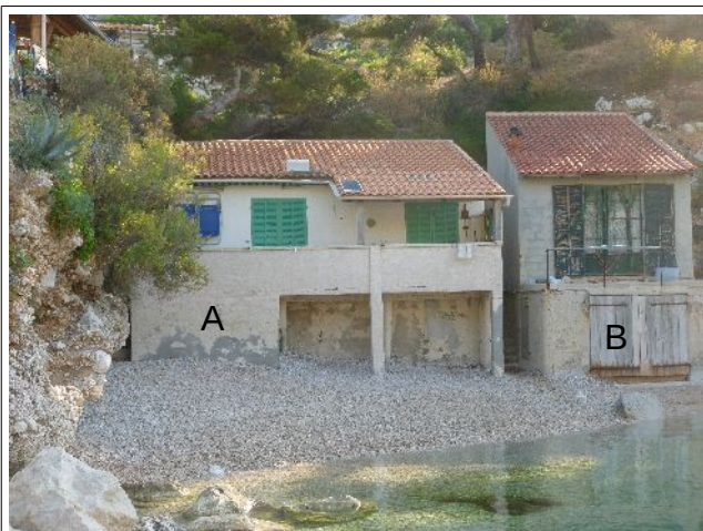
La façade - Photo 1
