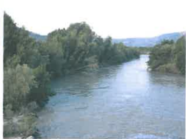
Aspect du cordon de ripisylve depuis le seuil 8 Photo G. Durand / Naturalia
