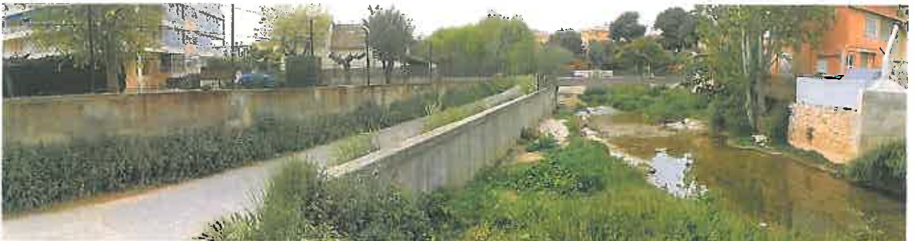
Photo N°14 Traverse de la Reppe – La Reppe
