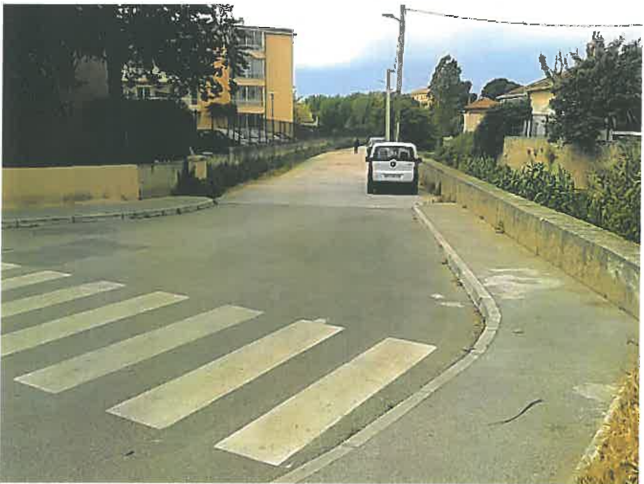
Photo N°16 Traverse de la Reppe
