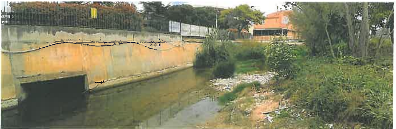
Photo N°13 Traverse de la Reppe – La Reppe
