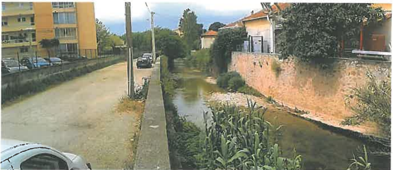
Photo N°8 Traverse de la Reppe – La Reppe
